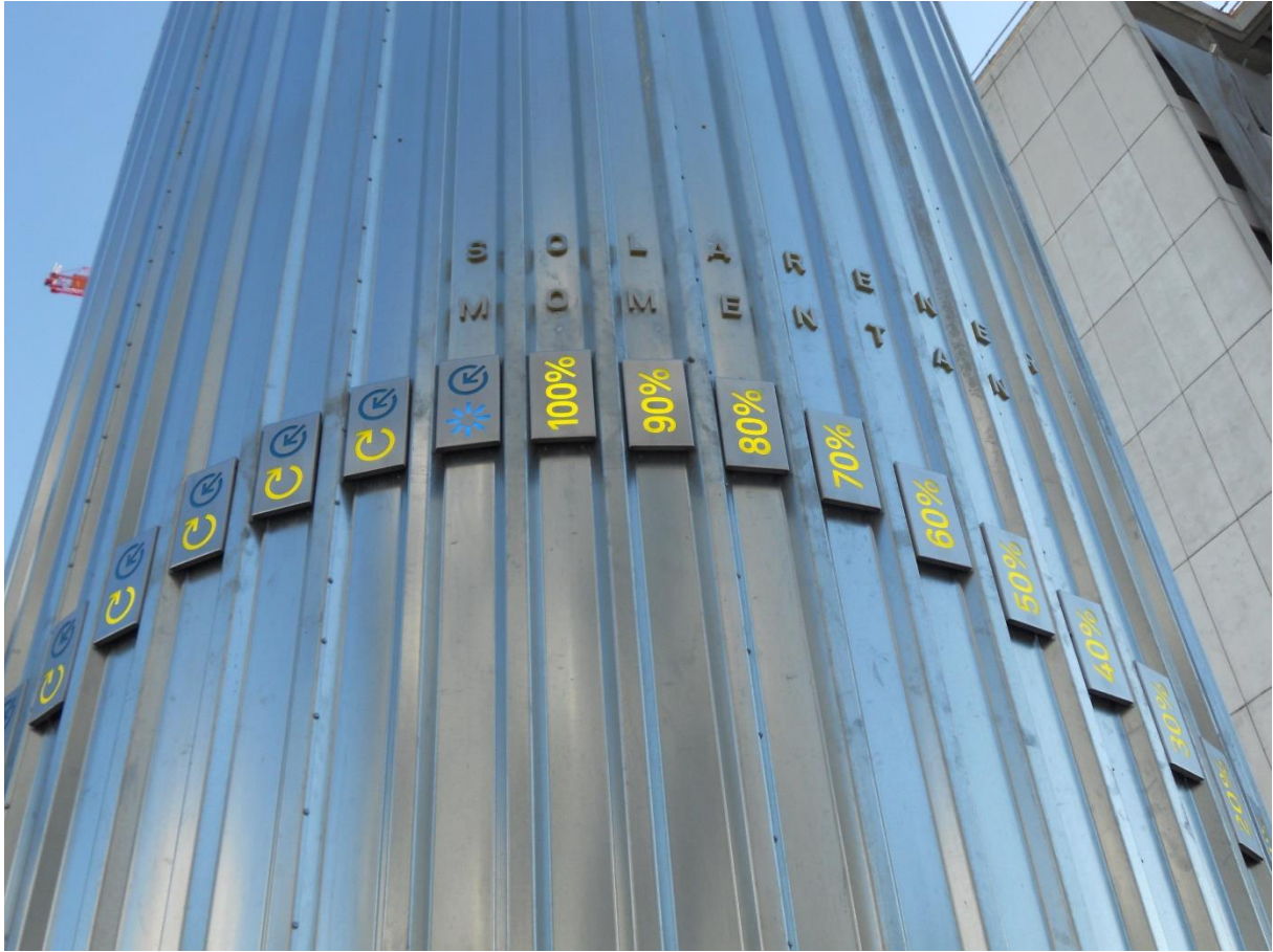
Abbildung 2: Solar-Pufferspeicher 200.000 Liter mitten im Stadtwerk Lehen
